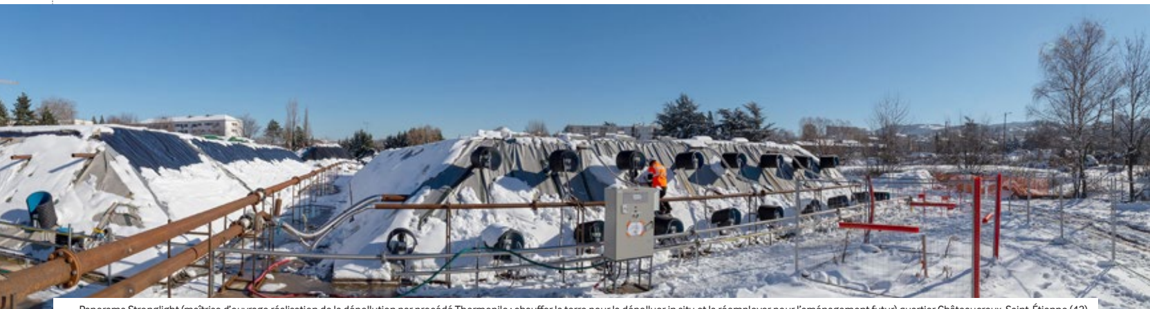
Panorama Stronglight (maîtrise d'ouvrage réalisation de la dépollution par procédé Thermopile : chauffer la terre pour la dépolluer in situ et la réemployer pour l'aménagement futur) quartier Châteaureux, Saint-Étienne (42).
