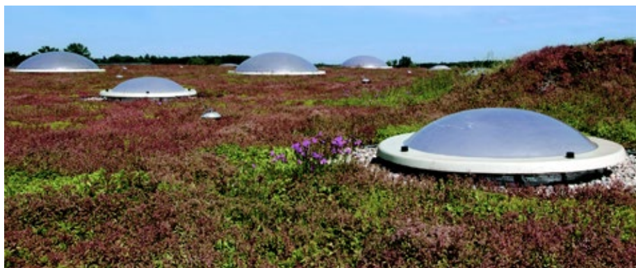
Toit du centre intercommunal de traitement de l'eau avec ses puits de lumières.
