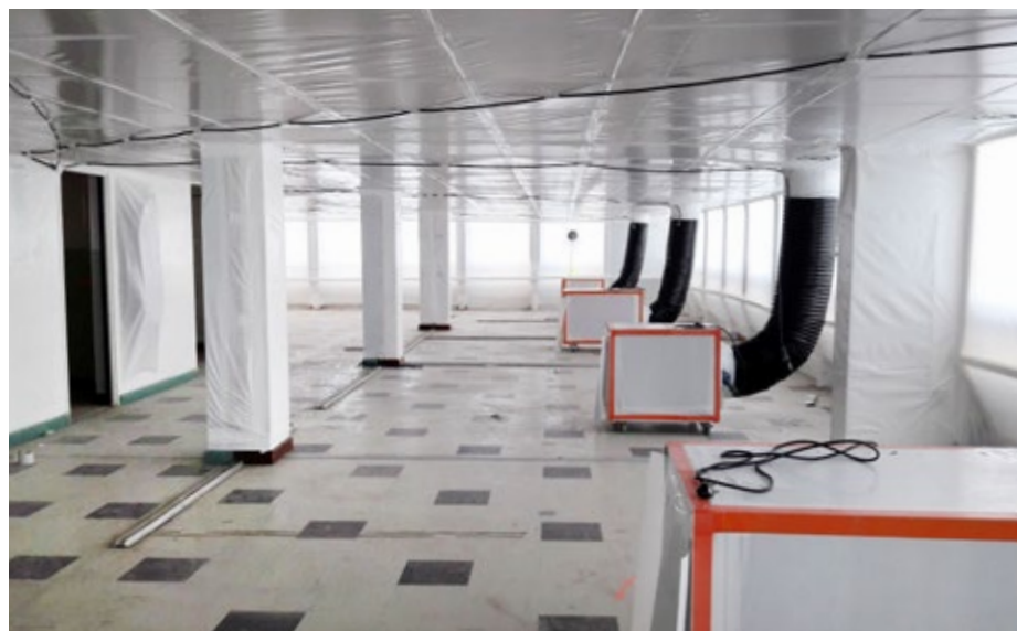
Désamiantage en cours des plateaux de la Tour Loubet (Bâtiment de la CPAM de 15 étages), Saint-Étienne (42).
