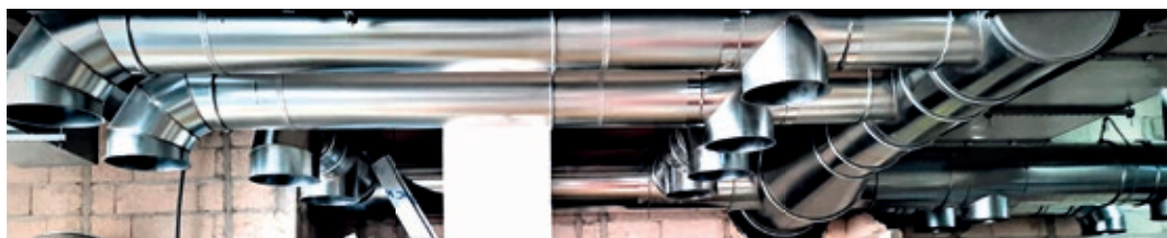
CONDUITS METU FORM, 400°C – 120 min, au-dessus des hottes.
