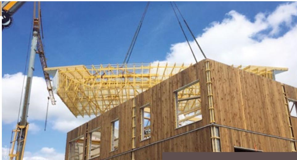
Levage de la charpente, après assemblage au sol
